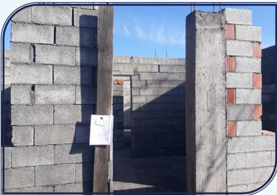
İlçemiz sınırları içerisinde inşa edilen kaçak yapıların tespiti yapılıyor
