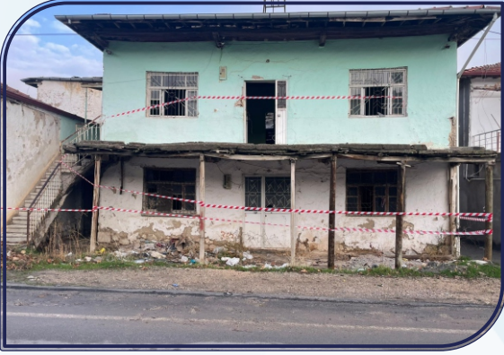
İlçemizde bulunan metruk binaların tespiti yapılarak emniyete alınıyor
