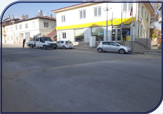
İlçemizde alt yapı çalışmaları sonucunda zarar gören yollar ve kaldırımların tespiti yapılarak gerekli kurumlara bildirildi
