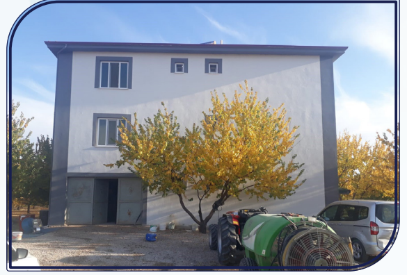
İlçemiz sınırları içerisinde inşa edilen kaçak yapıların tespiti yapılıyor.
