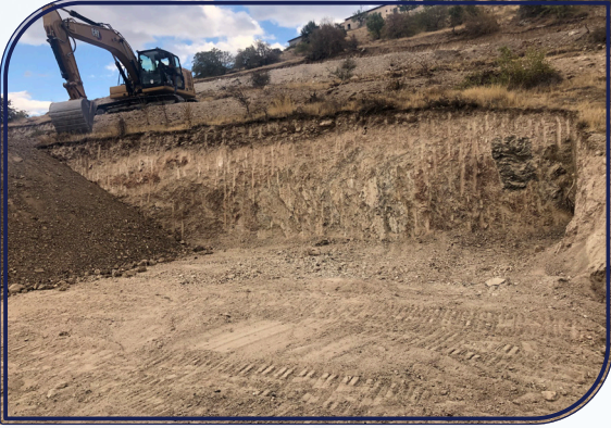
Çatalbahçe mahallesinde Belediyemize ait arazi üzerine 2090 m2'lik Kültür Merkezi yapımı için temel kazı çalışması tamamlanmıştır.
