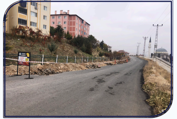
Toki yolunda bulunan kanal yoluna aydınlatma işlemleri yapılmıştır.
