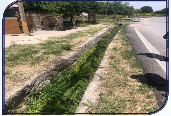
Başpınar mahallesinde bulunan kanal üzeri kapatılması yapım işi.
