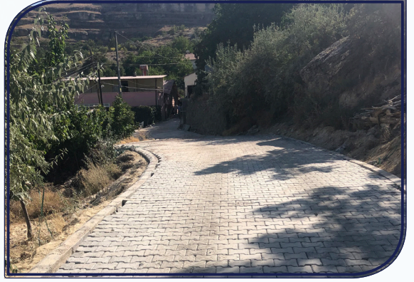
Belediyemize bağlı Kasımuşağı Mahallemizin kilit taşı döşeme işini tamamladık.
