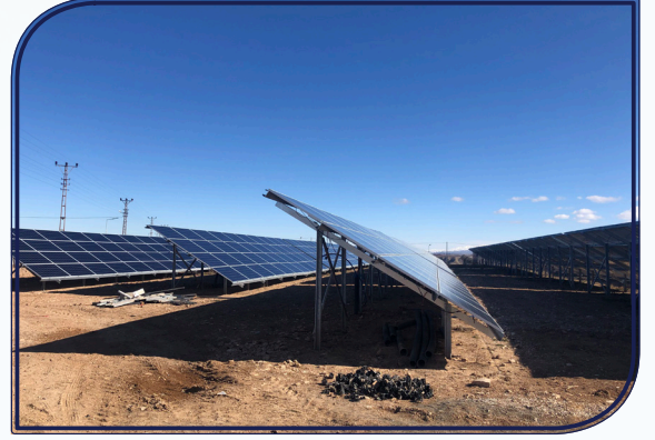
Belediye gelirlerini artırmaya dönük bir proje olarak 1 MW gücündeki Güneş Enerjisi Santralini tamamladık.
