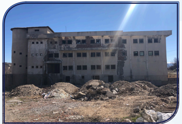
2019 Yılında çürük raporu verilen Akçadağ Kültür Merkezinin yıkımı tamamlanmıştır.
