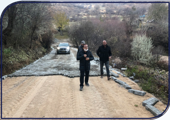
Belediyemize bağlı Keklikpınarı Mahallemizin kilit taşı döşeme işini tamamladık.
