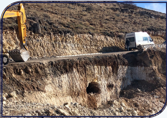
Levent Vadisi düzleştirme projemiz kapsamında WC ve Lokanta inşaatlarımız sürüyor.
