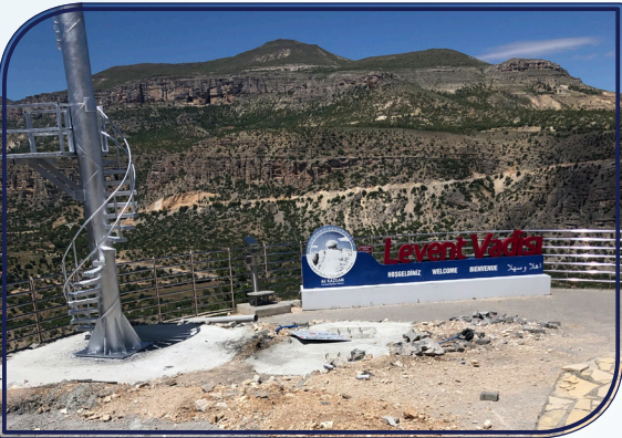
'Dünya Mirası Levent Vadisi' Projesi kapsamında, Zipline, Yamaç Salıncağı, Dev Salıncak, Trambolin yapımları tamamlanmış; Slickline alanı çalışmalarında sona gelmiştir.
