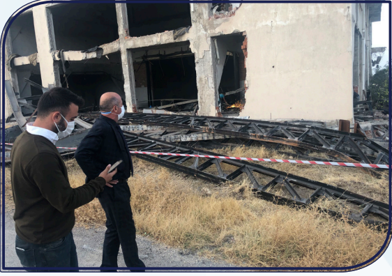
2019 Yılında çürük raporu verilen Akçadağ Kültür Merkezi'nin yıkımı tamamlanmıştır.
