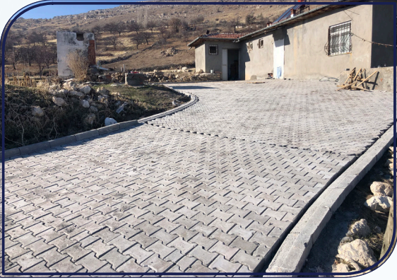
Belediyemize bağlı Yalınbudak Mahallemizin kilit taşı döşeme işini tamamladık.
