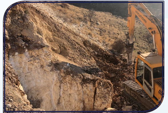
Levent Vadisi düzleştirme projemiz kapsamında WC ve Lokanta inşaatlarımız sürüyor.
