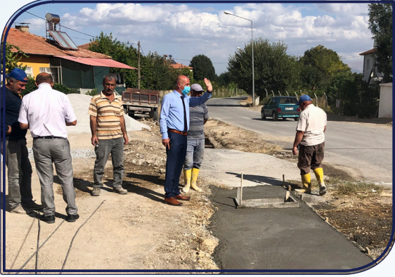
Başpınar mahallesinde bulunan kanal üzeri kapatılması yapım işi.
